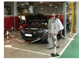
5. Impedir el acceso a elementos en tensión y señalizar la zona
